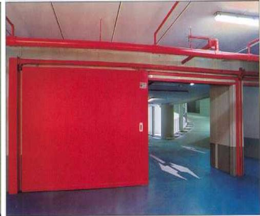
**Dire che una porta è REI 120 significa avere la certezza di resistenza, impermeabilità e barriera al calore per 120 minuti**
